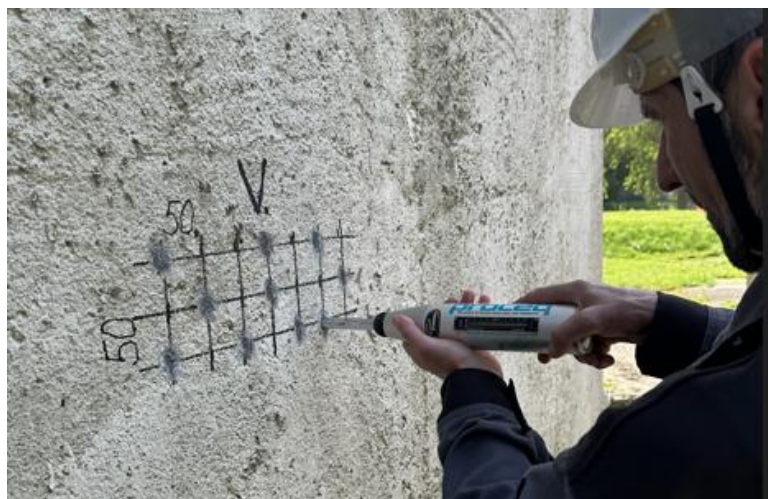
Pav. 6.2 betono stiprio testas Šmidto plaktuku
